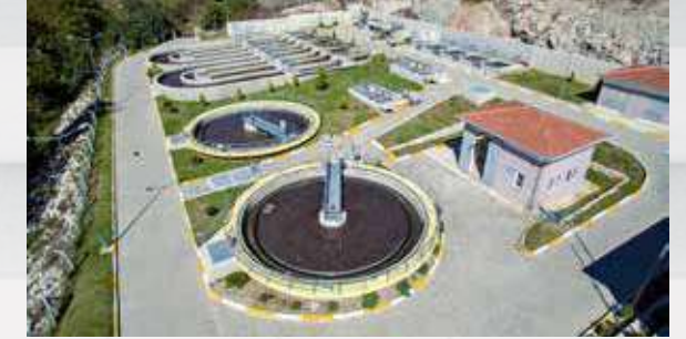
Dursunbey Atıksu Arıtma Tesisleri
